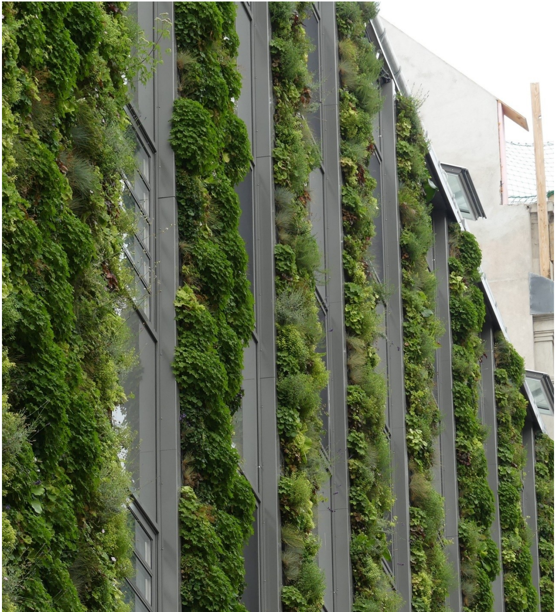
Abbildung 8: Fassadenbegrünung des Krankenhauses der Barmherzigen Schwestern in Wien
